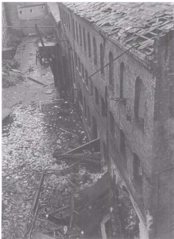
Den københavnske modstandsorganisation BOPA dokumenterede selv sabotagen ligesom politiet foto-graferede skaderne. Ovenstående foto blev knipset af BOPA-sabotøren Kai Ludwigsen under eller umiddelbart efter sprængningen af fabrikken. (Friheds-museet).
